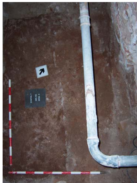
General final de la cala realitzada a la zona 3.
