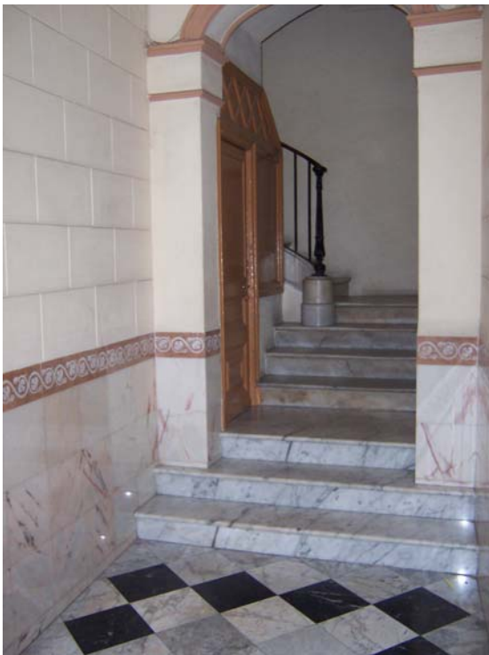
Vista de la Zona 1, vestíbul de la finca i primer tram d'escaleres.
