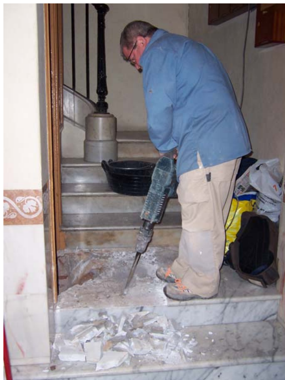
Moment del desmuntatge del replà i del tram d'escala de la Zona 1.
