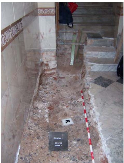
Detall de l'estat final de la rasa practicada a la zona 1.
