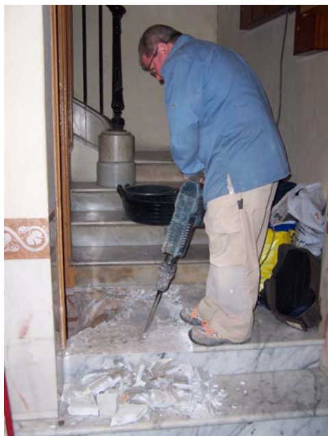
Rebaix del tram d'escala i del replà de la zona 1.
