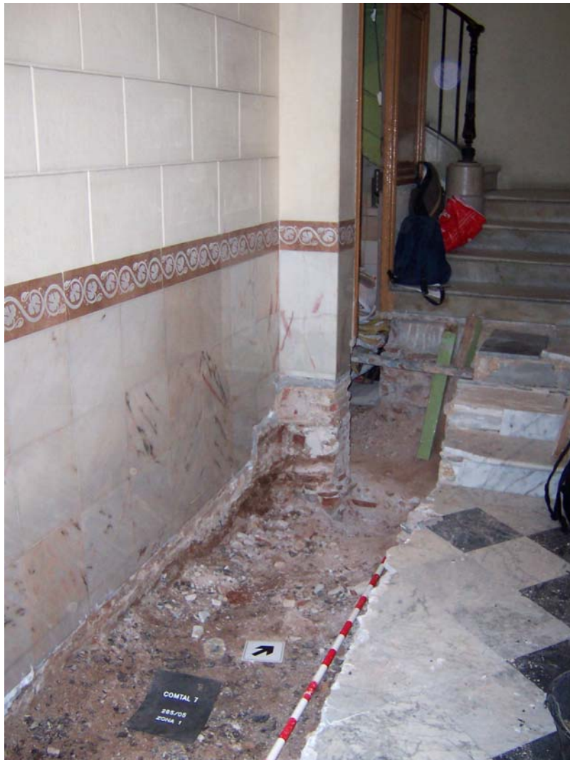
Estat final de la cala a la Zona 1.
