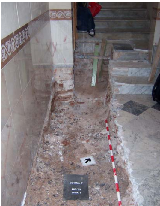
Estat final de la cala de la Zona 1.
