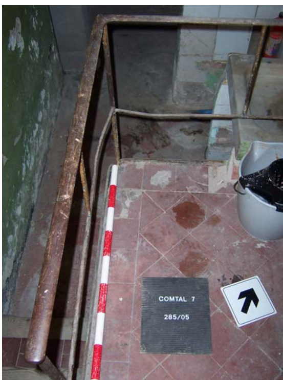
Estat de la Zona 3 abans del desmuntatge de l'escala, del safareig i el paviment.
